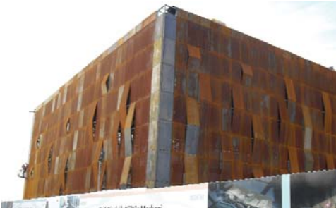
Raif Dinçkök Kültür Merkezi - Corten A Cephe Kaplama
