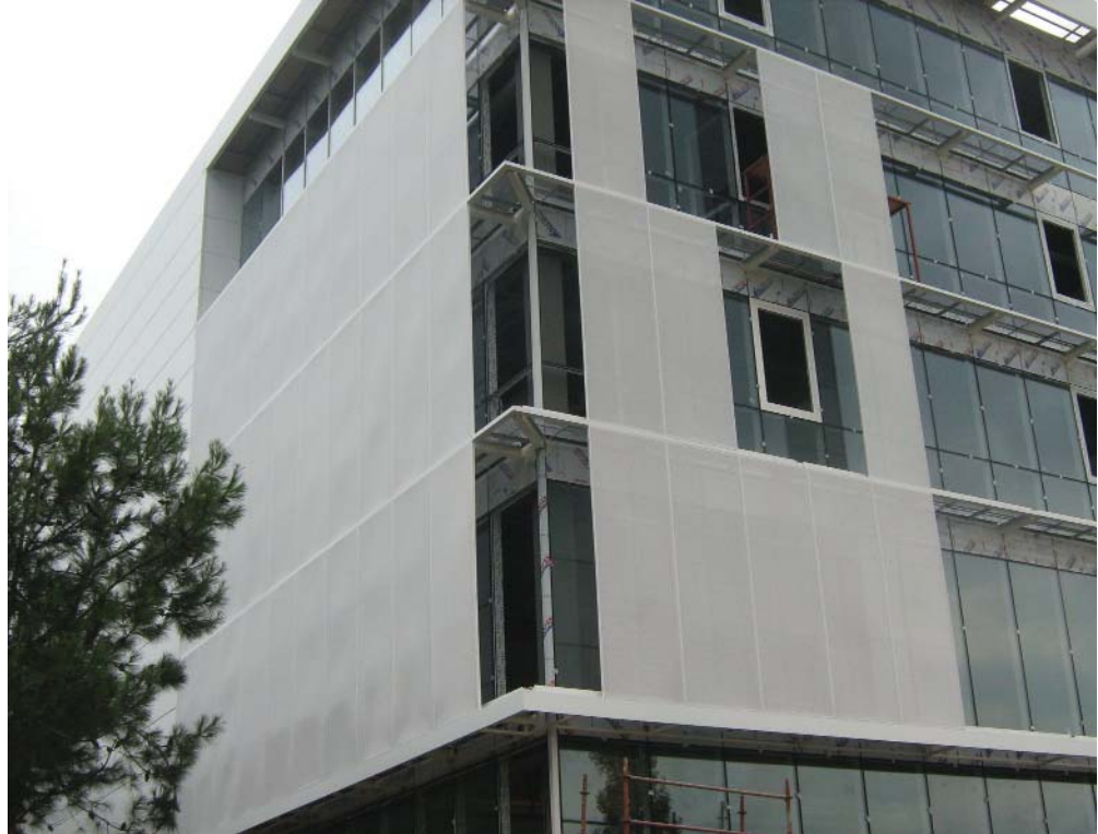
İTÜ Derslik Binası - Perforeli Alüminyum Cephe Panelleri ve Yürüme Yolları
